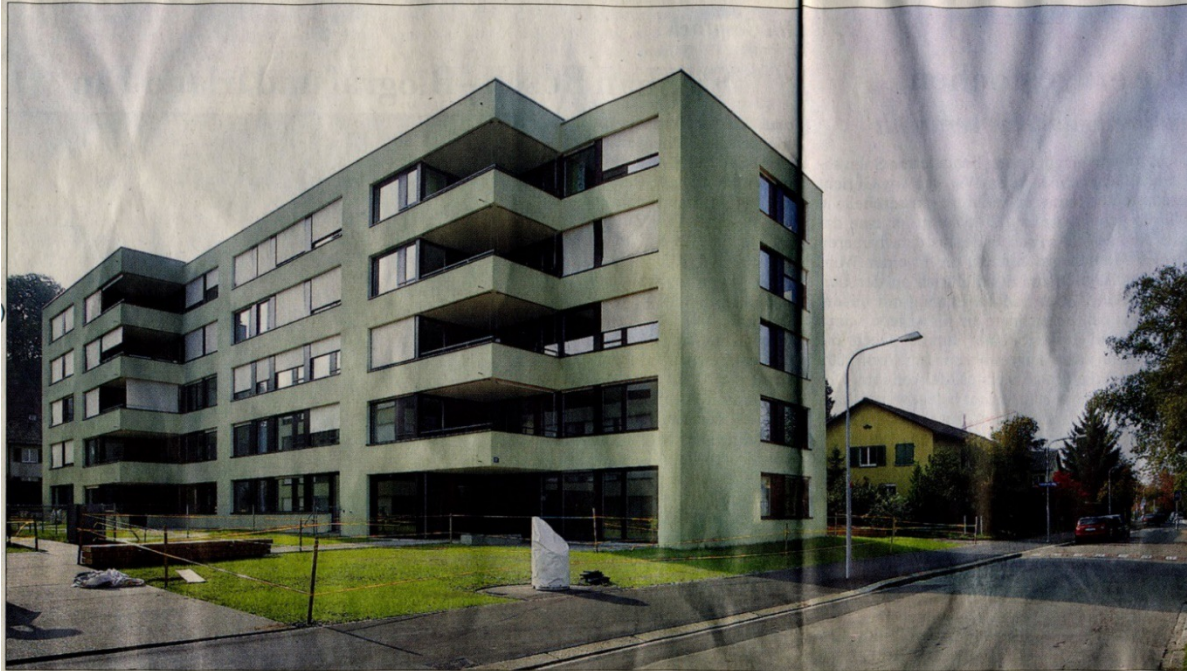
Die Neubauten stehen quer zur Katzenbachstrasse und verbinden die beiden benachbarten Grünräume der Freizeitanlage und des Buhnügels. CHRISTIAN BEUTLER
